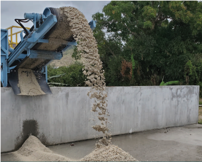
Descarga de gravas y arenas recuperadas mediante el sistema JADAIR Redi-Wash.
