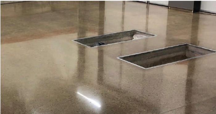
El contratista terminó el trabajo en tan solo 3 horas, y la superficie tratada quedó perfecta para adherir la nueva capa de concreto que posteriormente fue pulida y abrigantada con diamante.
