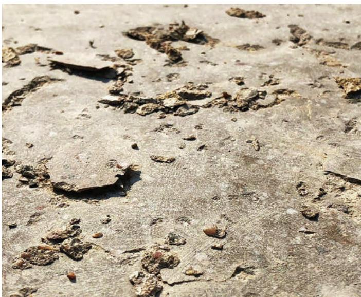
El piso del garaje severamente deteriorado previo hidrodemolición
