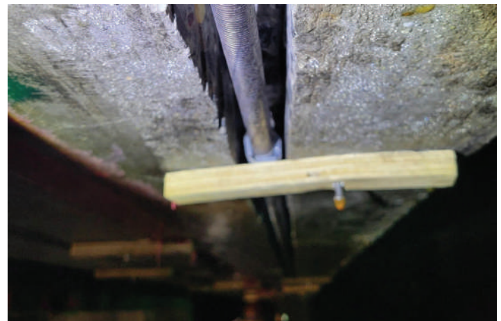
Figura 5. Las barras NSM se apoyaron mediante tiras de madera contrachapada ancladas al concreto adyacente
