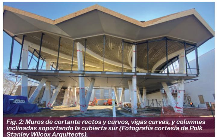
**Fig. 2: Muros de cortante rectos y curvos, vigas curvas, y columnas inclinadas soportando la cubierta sur (Fotografía cortesía de Polk Stanley Wilcox Arquitects).**
