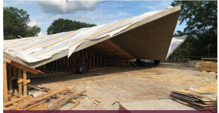
**Fig. 3:** Fotografía del avance tomada desde el piso de baile, mostrando la plataforma del techo después de que se han removido una parte de los marcos y el encofrado (Fotografía cortesía de Polk Stanley Wilcox Architects).
