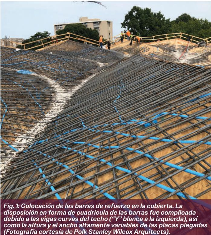
**Fig. 1: Colocación de las barras de refuerzo en la cubierta. La disposición en forma de cuadrícula de las barras fue complicada debido a las vigas curvas del techo ("Y" blanca a la izquierda), así como la altura y el ancho altamente variables de las placas plegadas (Fotografía cortesía de Polk Stanley Wilcox Arquitects).**
