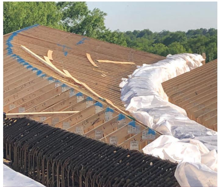
**Fig. 4:** Fotografía del avance tomada desde el techo de un edificio del museo existente. Para la nueva estructura de cubierta plegada se colocaron marcos de encofrado. Otras características visibles incluyen un nuevo muro y un parapeto adyacente a la estructura existente, así como una membrana de curado para las vigas curvas de la cubierta plegada (Fotografía cortesía de Polk Stanley Wilcox Architects).
