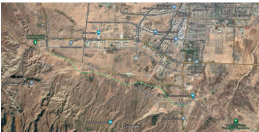
Fig. 2: Ubicación de las instalaciones de protección contra flujo de lodo.
