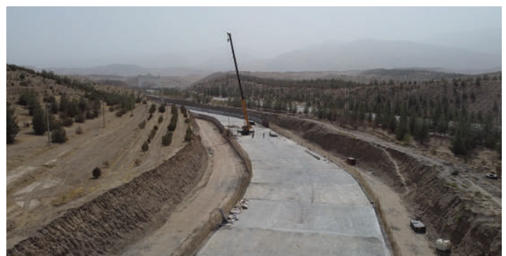
Fig. 6: Losas de canal después de la colocación del concreto.
