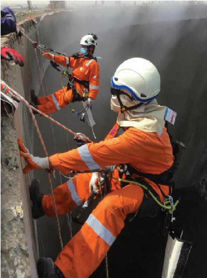
Fig. 10: Acceso industrial por cuerda desde lo alto de una estructura elevada.
