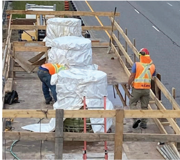
Fig. 1 Uso de barras PRFV en pías de puentes en Canadá.
