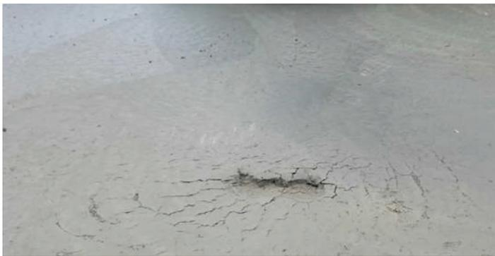
**Fig. 2:** Desgarro de la superficie durante el allanado.
