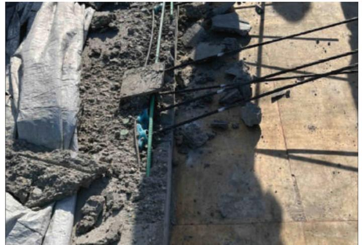
Fig. 12: Los tendones de una losa de concreto construida con concreto Tipo IL se tensionaron basándose en una calibración de madurez para concreto de cemento Tipo I. Se sobrestimó la resistencia del hormigón de cemento Tipo IL, lo que provocó reventamientos en las losas.
