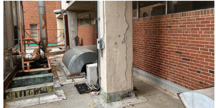
**Fig. 3:** Grietas verticales y delaminación del concreto en una columna.
