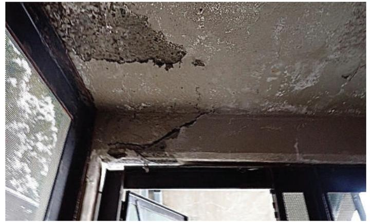
Fig. 4: Esta amplia grieta diagonal cerca de un soporte indica la necesidad de apuntalamiento e investigación adicional.
