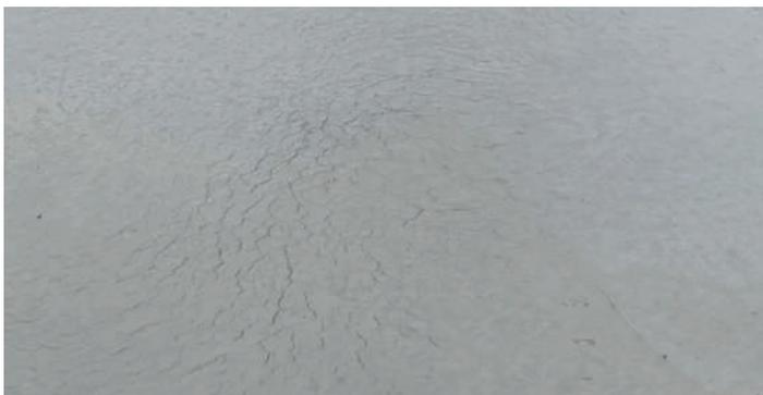
**Fig. 3:** Grietas en la superficie durante la operación de allanado, el concreto debajo de la superficie todavía es plástico.
