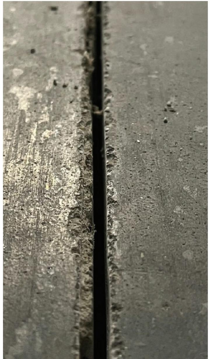
*Fig. 9: El corte demasiado temprano produce bordes de las juntas desmoronamientos (fotografía cortesía de Scott Metzger, Metzger/McGuire).*
