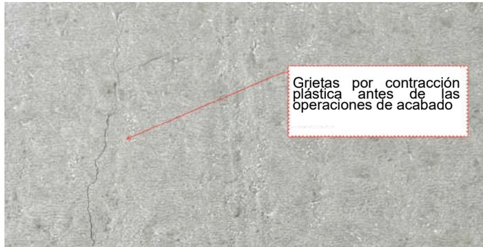
**Fig. 1:** Grietas por contracción plástica antes de las operaciones de acabado.
