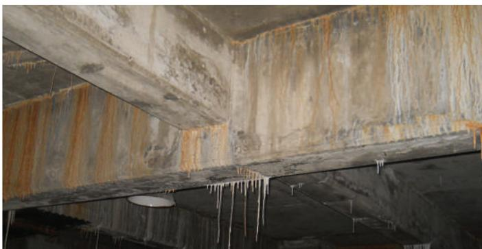
Fig. 1: Filtraciones con manchas de corrosión en una estructura de pórticos de un estacionamiento existente.
