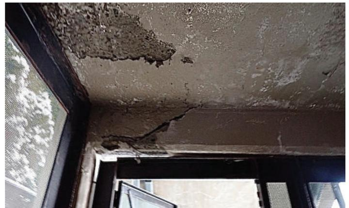
Fig. 5: Barras de refuerzo corroídas en un balcón (en reparación).
