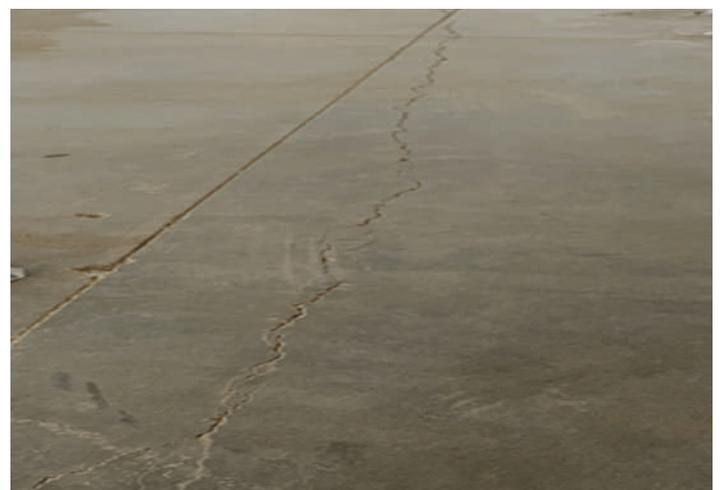
*Fig. 10: El corte con sierra demasiado tarde produce grietas (fotografía cortesía de Scott Metzger, Metzger/McGuire).*
