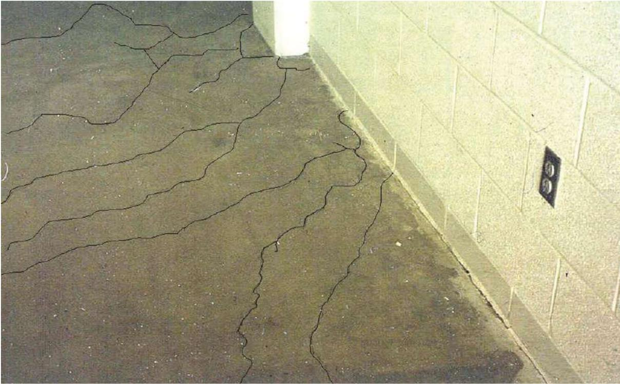
*Fig. 1: Losa de concreto con grietas radiales debidas a un soporte insuficiente durante la construcción de un edificio.*
