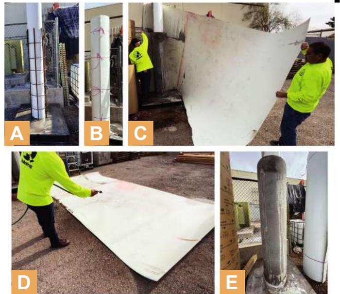
**Fig. 6:** Aplicación en sitio: (a) refuerzo de acero instalado (b) FLF colocada y llena de concreto; (c) remoción del laminado después de fraguado el concreto; (d) limpieza y almacenamiento del laminado para uso futuro (e) superficie de concreto lisa y sin marcas en espiral.
