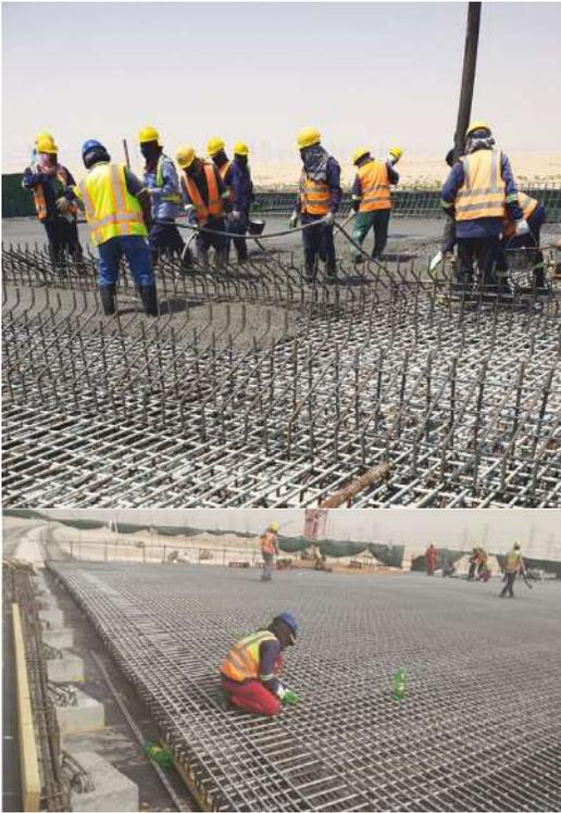
**Fig. 6: Instalación de barras de GFRP y colocación de concreto en el puente SPARK. proyección del costo del ciclo de vida del proyecto entre GFRP y ECR durante 100 años.**
