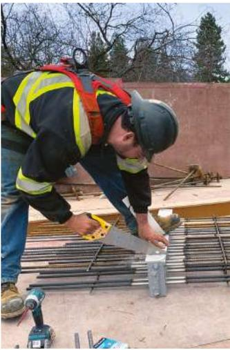
*Fig. 2: Un módulo de ruptura de puente térmico puede cortarse con serrucho de manera manual en caso de ser necesario*
