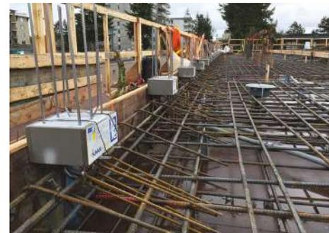
*Fig. 4: Se instalan roturas de puente térmico para parapetos en las cimbras de madera verticales de parapetos y se atan a las barras de refuerzo horizontales. Las barras de refuerzo se fabrican para transferir tanto adherencia como cortante a través de la capa de aislamiento.*
