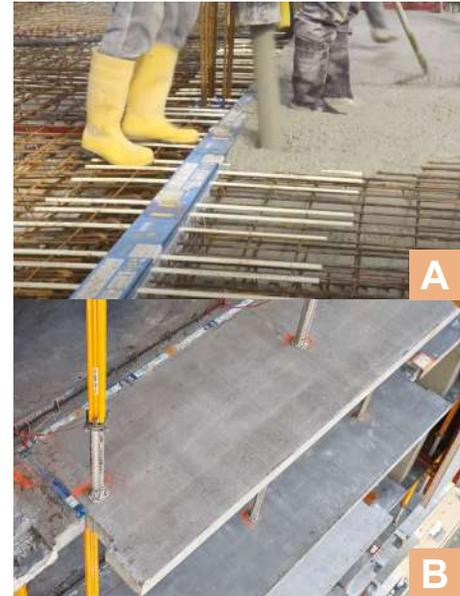
*Fig. 3: Roturas de puente térmico estructurales en balcones: (a) durante la colocación del concreto del balcón, y (b) después de la colocación del concreto del balcón y de la losa. Nota: Los módulos se instalan con la placa superior al ras de la estructura exterior de concreto. Las barras blancas son barras de GFRP.*
