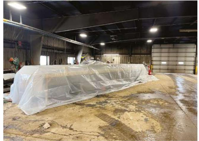
Figura 9: Viga compuesta de acero y CAR cubierta en plástico con calefacción integrada para promover curado de CAR
