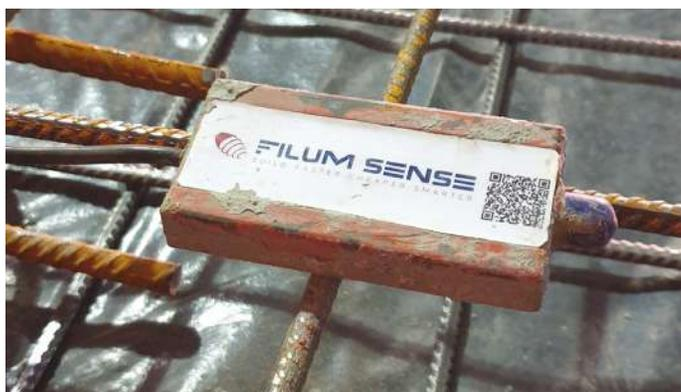
Figura 1: Una unidad de sensor montada en barras de refuerzo
