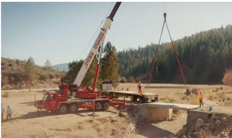
**Figura 4: Colocación de las vigas cajón**
