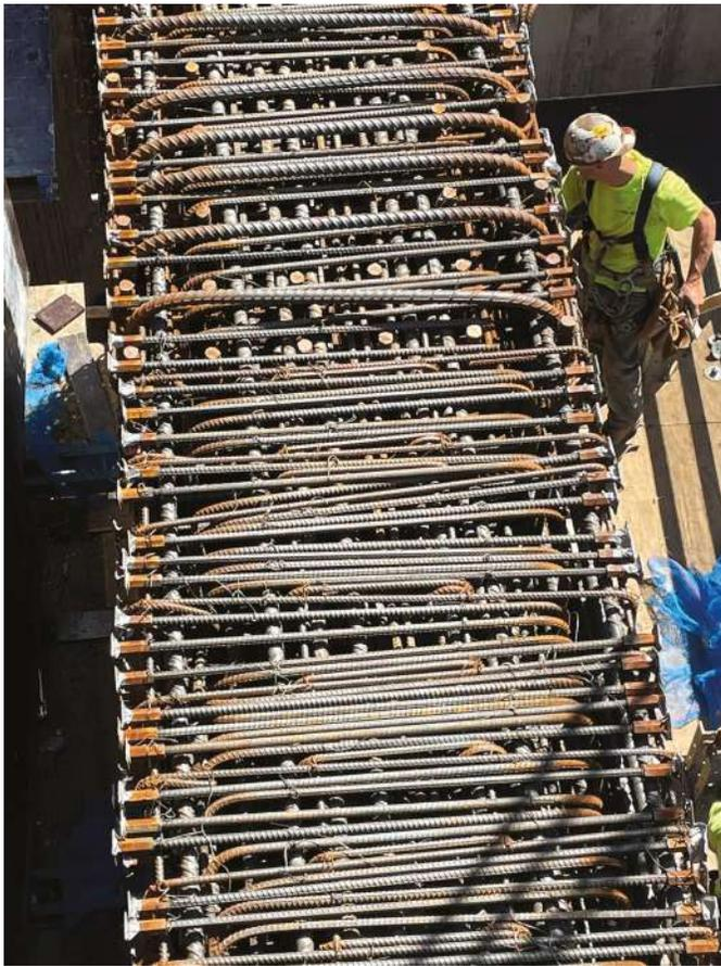
Figura. 8: La densidad de las varillas de refuerzo de este elemento se aproximaba a las 800 lb/yd<sup>3</sup>. Después de la construcción, el ingeniero cambió el tamaño de las varillas, las agrupó y reorganizó los empalmes para que hubiera acceso para la colocación del concreto.
