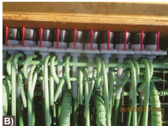
**Figura 1:** Ejemplos de montajes de refuerzo que plantearon retos de colocación para el contratista: (a) un muro antisísmico; y (b) una zona de anclaje para tendones de postensado
