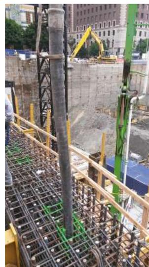
**Figura 3:** Zonas de acceso para la manguera de bombeo y para el vibrador (pintura verde) en la parte superior de un muro de contención congestionado. Estas zonas estaban separadas por 10 pies en la parte superior del muro y eran continuas en toda la altura del muro. Las zonas se coordinaron previamente con el ingeniero y la agencia de inspección.
