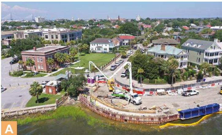
baja para llevar a cabo la colocación del concreto sin necesidad de realizar un desagüe adicional. Con la Fase II prácticamente terminada en abril de 2022, el uso exitoso del refuerzo de GFRP para las Fases I y II de este proyecto se hizo realidad y fue fundamental para la selección de varillas de GFRP para la Fase III.
