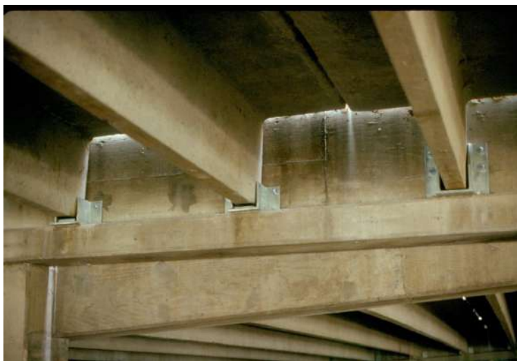
Figura. 2: Incorporación de soportes de acero bajo los vástagos de las T
