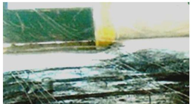
Figura. 2: Ejemplos del refuerzo requerido en losas apoyadas en pilotes diseñadas con el método de diseño sueco
