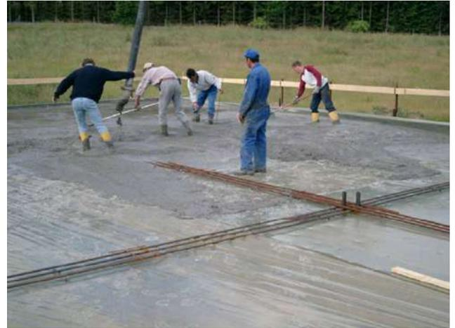
*Figura 4: Losa elevada de SFRC construida con concreto fluido. Diseñada según el método descrito en el reporte ACI 544.6R-15, esta losa incluye un refuerzo de integridad -varillas de refuerzo inferiores que se extienden de columna en columna- para evitar el colapso progresivo en caso de sobrecarga o daños*
