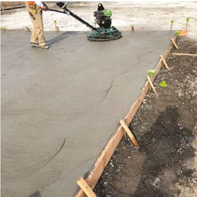
*Figura. 5: Después de la flotación del canal y el tiempo de espera, los trabajadores usaron una allanadora mecánica de tipo helicóptero de 36 in (914 mm) con una bandeja*
