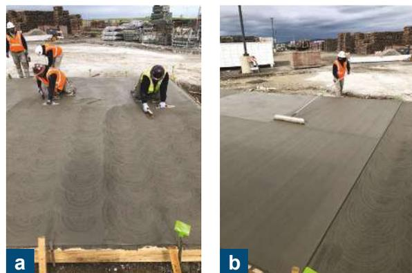
Figura. 1: Aplicación de acabados a un panel de prueba: (a) acabado de remolino con cepillo; y (b) acabado de escoba
