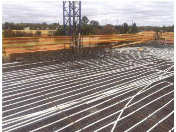
*Figura.7: Se instaló un sistema de construcción activado térmicamente (TABS, por sus siglas en inglés) en los pisos de la losa de concreto y en el techo para proporcionar calefacción y refrigeración al edificio*
