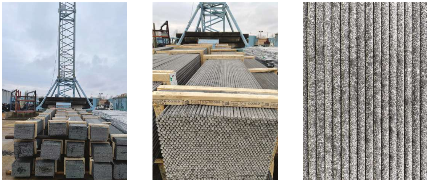
Fig. 1 Se utilizaron barras BFRP para reforzar los firmes de concreto.
