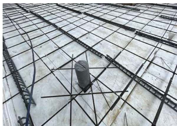
Fig. 4. Instalación de refuerzo BFRP No. 3 para uno de los firmes de concreto
