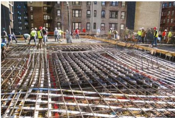
Figura 3: Construcción de una losa alivianada con tendones con adherencia en franjas duales (foto cortesía de LERA Consulting Structural Engineers)
