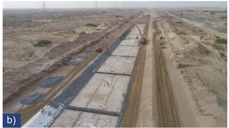
Fig. 5: Colocación del estrato de drenaje: (a) para la losa base; y (b) para los taludes. El estrato de drenaje para cada uno de los taludes del canal fue colocado después de la terminación del estrato aislante de la base.
