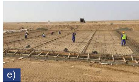
**Fig. 6:** La losa base se reforzó con mallas de barras de GFRP: (a) entrega de las barras; (b) almacenamiento de las barras en la capa aislante de un panel interior de la losa base (obsérvense las aberturas en la capa aislante para la posterior instalación de los tubos de drenaje); (c) colocación inicial de las barras; (d) montaje de la malla; y (e) preparación final de la malla de barras y del cimbrado de las juntas longitudinales.
