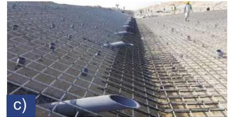
**Fig. 7:** Los lados inclinados del JEC-FMC se ataron a la losa base mediante barras de empalme hechas a la medida: (a) un trabajador lleva un juego de barras de empalme; (b) antes de la colocación del concreto, una vista general de una sección aguas arriba del JEC-FMC, mostrando las mallas, los agujeros de drenaje y el cimbrado del borde del canal; y (c) detalle del empalme en la intersección entre la base y el talud.
