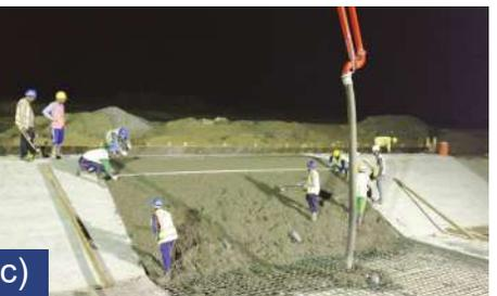
**Fig. 8:** Colocación del concreto en el CMI-CEJ: (a) capa de cierre en el talud; (b) un panel en la losa base; y (c) un panel en el talud lateral.
