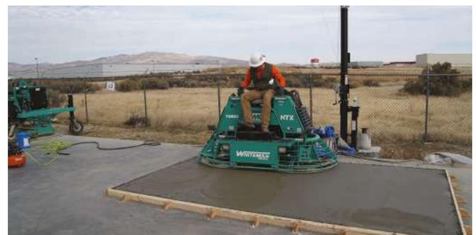
Figura 1: La losa 1 fue terminada usando un equipo para acabado superficial con operador montado encima, marca Multiquip HTX de 8 pies, (2.4 m). Esta losa fue usada como origen de los especímenes HT.”
