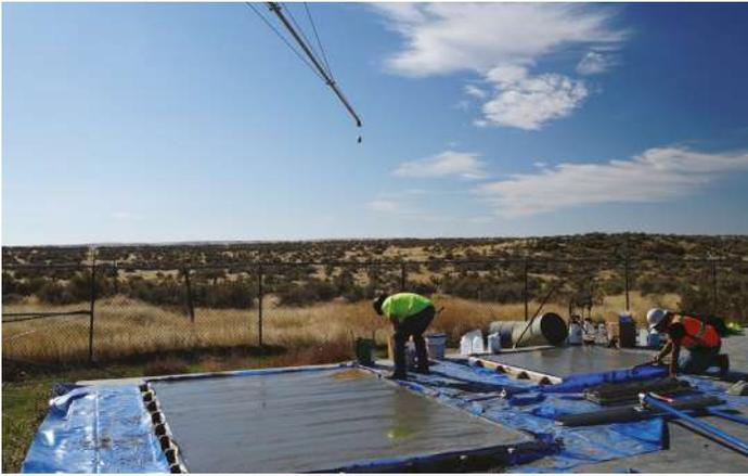
**Figura 2:** La losa 2 fue manualmente flotada y alisada, se esparció un endurecedor en polvo sobre la superficie. Esta losa fue usada como origen de los especímenes SF
