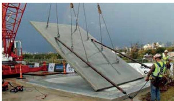
**Fig. 3: Tilt-Up de 114 mm (4.5 pulg.) de espesor diseñado con principios de diseño basados en el desempeño (de la Referencia <sup>16</sup>).**
