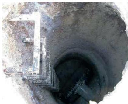
**Fig. 2: El sulfato de calcio (yeso) forma una masa espumosa blanquecina sobre el concreto**
