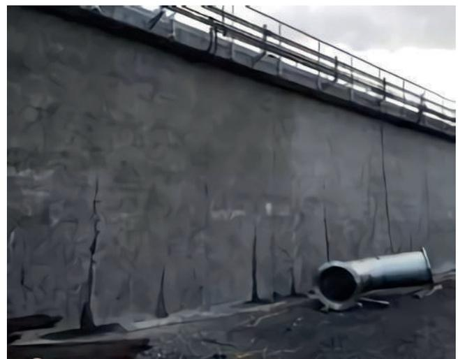
**Fig.3: Agrietamiento vertical de la pared resultado de la restricción de la base de concreto por cambios en volumen de T&C.**
