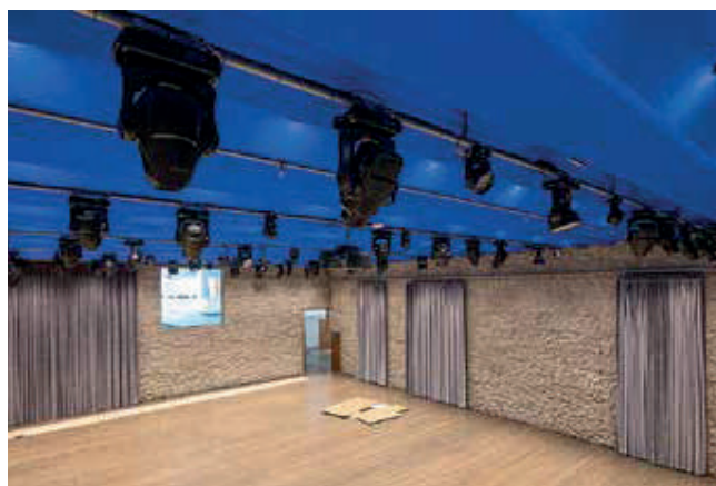
Fig.12: Studio K es una sala de usos múltiples que toma su nombre de la última inicial del difunto presidente. El espacio incluye paredes acústicas de concreto “texturizado” y un techo de concreto en forma de diente de sierra con luminarias integradas. El perfil del soffit de la losa de concreto se echó para que coincidiera con la forma del revestimiento azul. Aunque esta losa soportaba la cubierta verde y estaba postesada, no incluía formadores de huecos.
