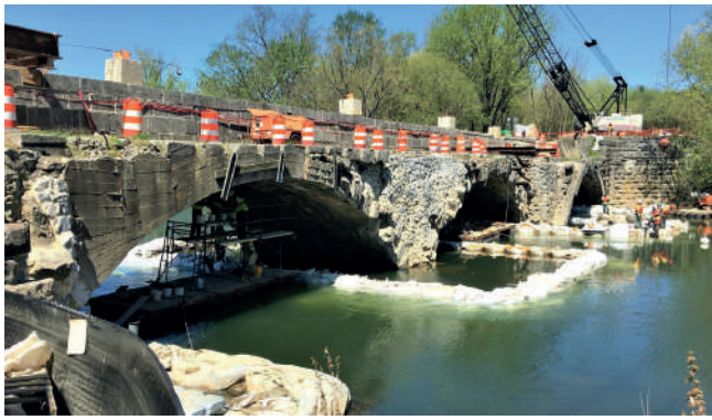
Reforzamiento de muelles y contrafuertes
