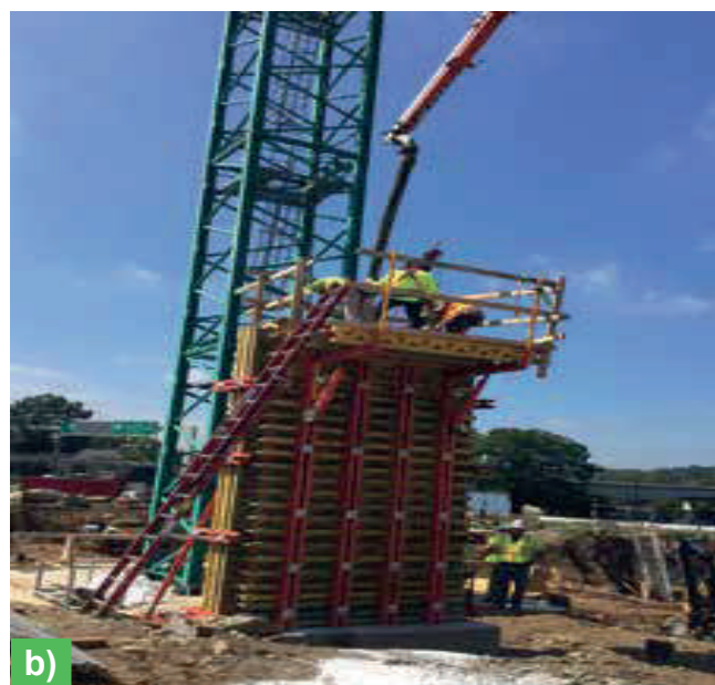
Fig. 16: Se utilizaron maquetas para evaluar los métodos de colocación: (a) bombeo en la base del encofrado; y (b) usar la manguera de la bomba de concreto como un conducto de caída
