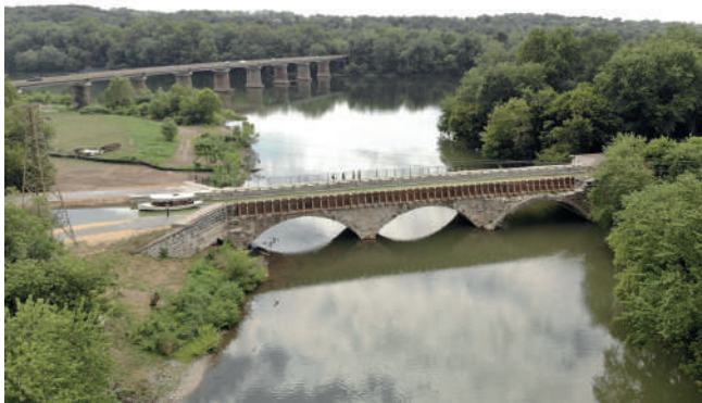
Acueducto Conococheague después de la construcción
