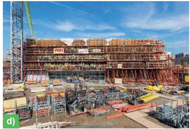
Fig. 9: La pared curva “característica” del “Skylight Pavilion” requería un sistema de encofrado extremadamente complejo: (a) las torres de encofrado iniciales sobre el sitio, adyacentes a la grúa torre (b) el acabado de la tabla machihembrada fue especialmente desafiante de crear en la superficie curva; (c) se requería un espaciado uniforme de los tirantes; y (d) la escala del muro se aclara con esta foto del equipo que conmemora la colocación final del concreto del muro.
