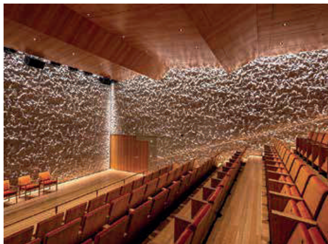
Fig. 13: El auditorio del Justice Forum también incluye muros de concreto texturizado. Los escalones, las aberturas de las puertas y las esquinas revelan desafíos creados para colocar los paneles de revestimiento y formar los mamparos, ya que se requería un patrón de unión continuo para evitar crear un patrón repetitivo discernible en el acabado texturizado. Además, muchas de las paredes tenían un revestimiento texturizado en un lado y un acabado en forma de tablero en el otro.
