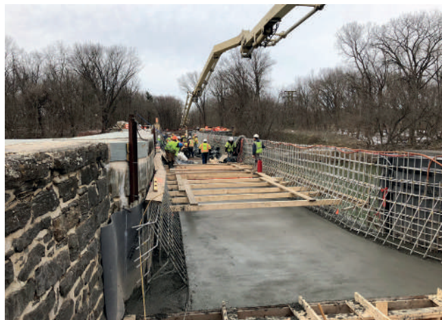
Colocación de la losa base (fotografía cortesía de Thomas, Bennett & Hunter, Inc.)
