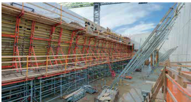
Fig.11: Vista de la cimbra interior y el encofrado necesarios para construir el muro curvo del River Pavilion.
