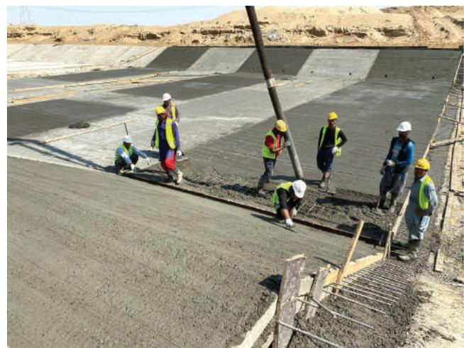
**Paso 6:** el concreto se coloca sobre las barras de refuerzo, se apisona y se consolida
