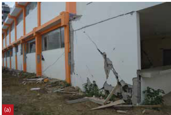
Fig. 5: Daños causados en dos edificios por el Terremoto de Ecuador de 2016: (a) fallas de corte en muros de relleno de mampostería; y (b) falla por cortante en una columna corta a nivel del suelo por encima de las paredes de relleno (después de la Referencia 23, con licencia CC BY-SA 3.0)
