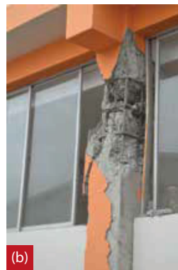
Fig. 5: Daños causados en dos edificios por el Terremoto de Ecuador de 2016: (a) fallas de corte en muros de relleno de mampostería; y (b) falla por cortante en una columna corta a nivel del suelo por encima de las paredes de relleno (después de la Referencia 23, con licencia CC BY-SA 3.0)
