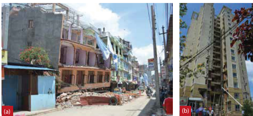
Fig. 3: Edificios dañados en el terremoto de Nepal de 2015: (a) edificio de poca altura (después de la Referencia 18, con licencia CC BY-SA 3.0); y (b) edificio de gran altura (después de la Referencia 19, con licencia CC BY-SA 3.0)
