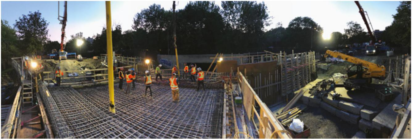
Fig. 12: Uno de los dos puentes que se están construyendo en Montreal, compuesto de concreto con 10% de cemento en sustitución con PVM Tipo GS. Los puentes serán instrumentados y supervisados a detalle por la Universidad de Sherbrooke y el Ayuntamiento de Montreal (foto cortesía del Ayuntamiento de Montreal)
