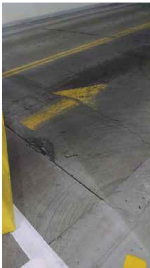
**Fig.3: Grietas y daños en la rampa de velocidad en la Estructura B (Nota: esta fotografía muestra una sección diferente de la rampa de velocidad que la ubicación de la falla final, pero la condición representada es ilustrativa).**
