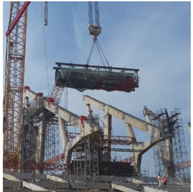
**Fig. 13:** Colocación de una viga circunferencia de concreto en el lugar. La viga está encerrada en un conjunto de armadura medida para permitir la terminación segura de las conexiones coladas en el sitio a los marcos radiales.
