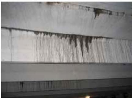
**Fig.2: Manchas de agua en un borde agrietado en la Estructura B**
