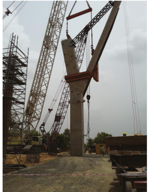
Figura 10: Vista de una columna HY después del montaje. Durante la operación, la columna fue reforzada por una armadura entre ambos brazos.
