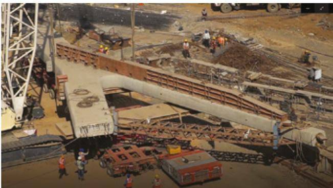
Figura 8: Una columna prefabricada es transportada al punto de montaje usando un trailer. Las piernas largas y delgadas de cada unidad de las columnas prefabricadas necesita apoyos fuertes, así como tensores para su montaje.
